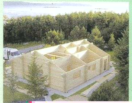
Der Aufbau des Hauses erfolgte dann ohne Kran, hier mussten alle Balken gehieft werden.
