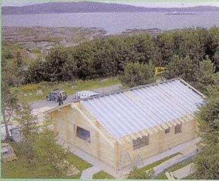
Platten um das Haus schützten die junge Raseneinsaat während der Arbeiten.
