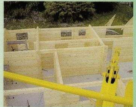
Der Aufbau des Hauses erfolgte dann ohne Kran, hier mussten alle Balken gehieft werden.
