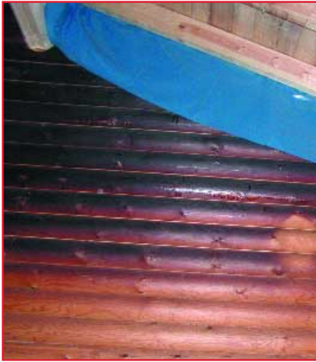
Der Dachaufbau ist rekonstruiert, die Balkenlagen vor der Bearbeitung.
