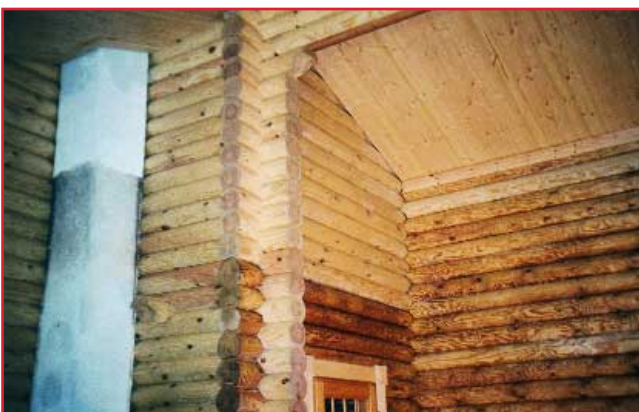
Zur Sanierung wird das Blockhaus bis zur Höhe des Brand Schadens demontiert, die zerstörten Blockbalken ausgetauscht und anschließend erfolgt die Instandsetzung.
